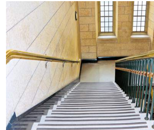
Door de dubbele streep kan deze markering verwarrend werken en struikelen in de hand werken.
