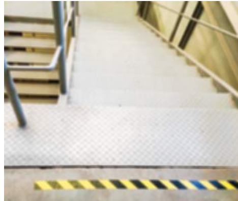
De zwart-gele markering is niet voldoende. Bij slechtziendheid 'verdwijnt' de diepte van de trap volledig.
