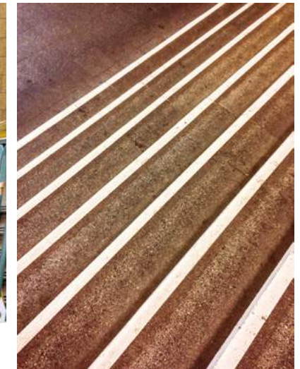
Markeer bij voorkeur elke trede rand over de volle breedte van de trap met een 45 mm dikke lijn.
